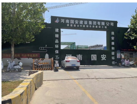
图 3.5-5 中梁新乐府建设现状
